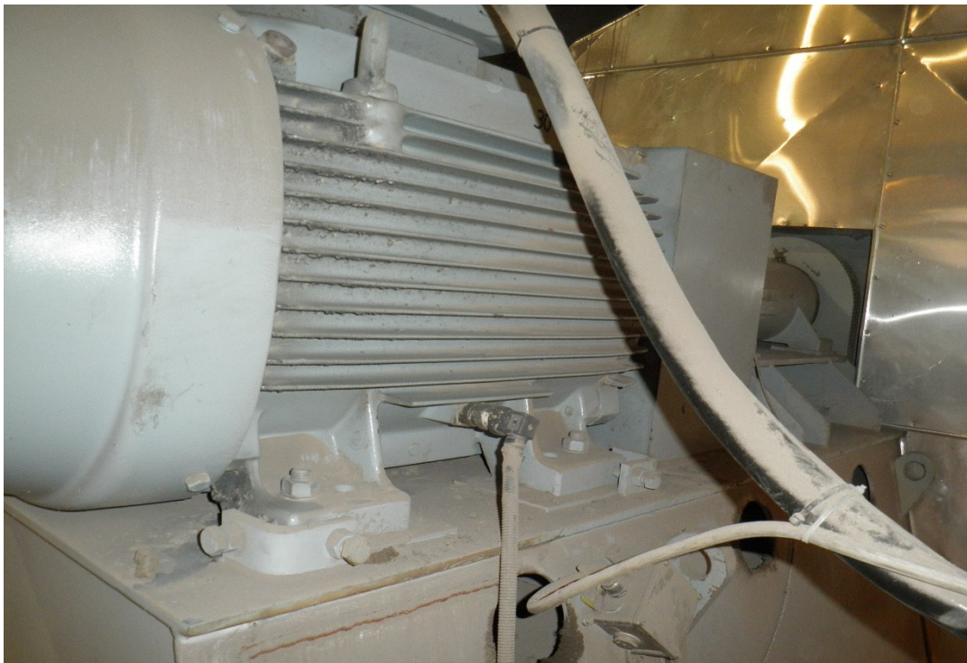
Obr. 6-1 Uchycení ventilátoru
