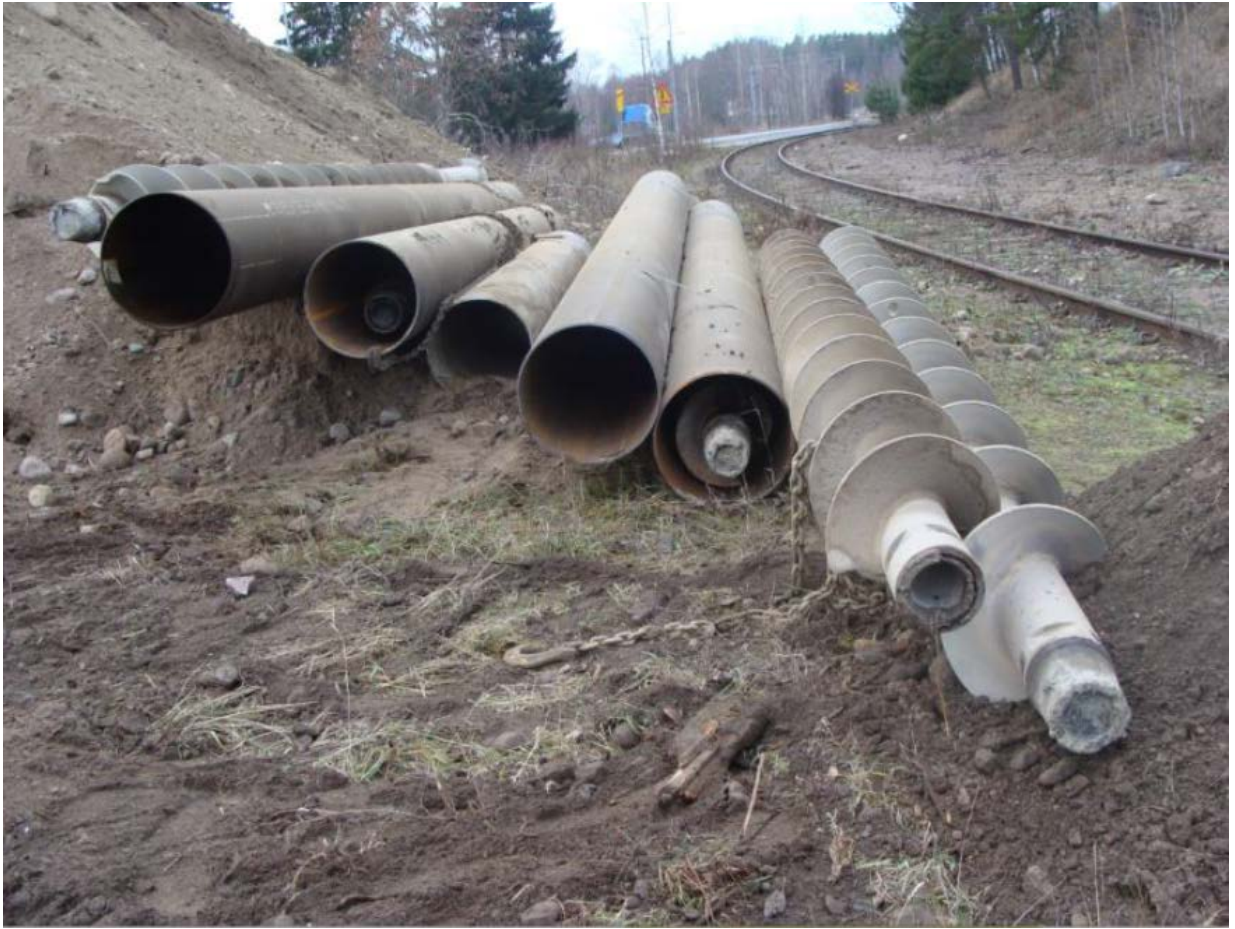
Kuva 9. Rautatien ja maantien alittavan viemärin vaakaporauksen poranteriä ja teräksisiä, yhteen hitsattavia suoja-putkia, joiden sisälle virtausputki sijoitetaan. © Sanna Rantanen
