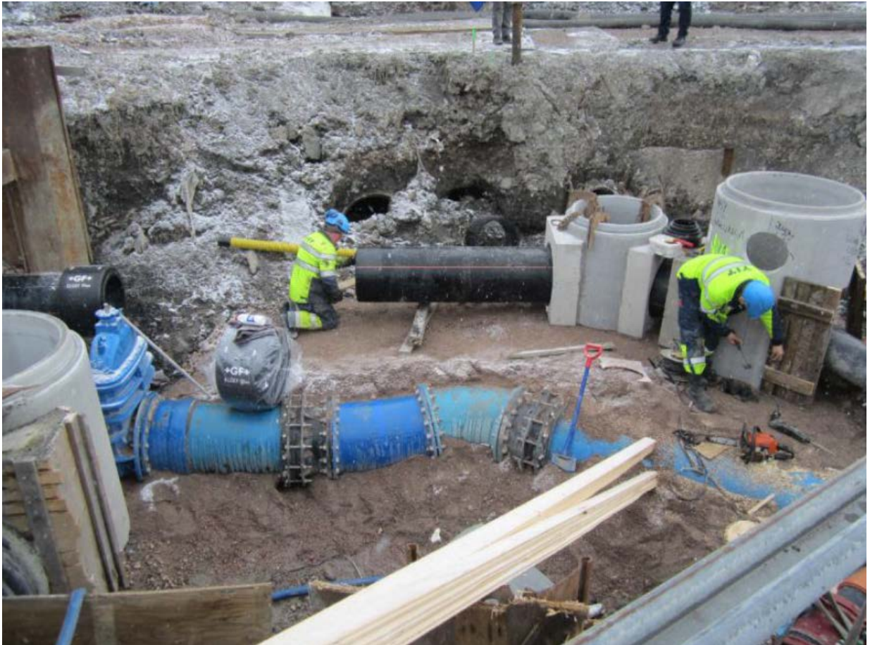
Kuva 8. Kuvan työmaalla saneerataan 600 mm vesijohtoa, 560 mm jätevesiviemäriä ja 1000 mm hulevesiviemäriä. Kuvassa tehdään jätevesiviemäriiliitosta olemassa olevaan verkostoon. © Sanna Rantanen
