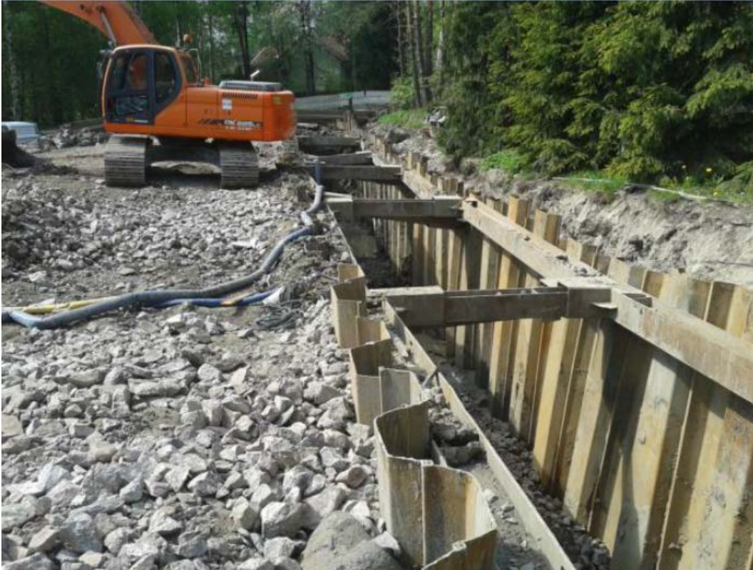
Kuva 5. Hyvin hoidettu työturvallisuus. Pontit on lyöty tiiviisti kiinni toisiinsa (ns. lyöty ponttiin), ja pontteihin on kiinnitetty kaivannon suuntainen vaakatuki sekä useita poikkitukia kaivannon poikki, jotka pitävät kaivannon pontit suorassa, jotta ne eivät taivu sisäänpäin. Syvässä kaivannoissa on erityisen tärkeää huomioida työturvallisuus. Kaivantojen seinien oikein suunniteltu ja mitoitettu tuentarakenne estää kaivannon seinämien sortumisen ja mahdollistaa työkonoiden turvallisen liikkumisen kaivannon läheisyydessä sekä ihmisten työskentelyn kaivannossa. © Sanna Rantanen
