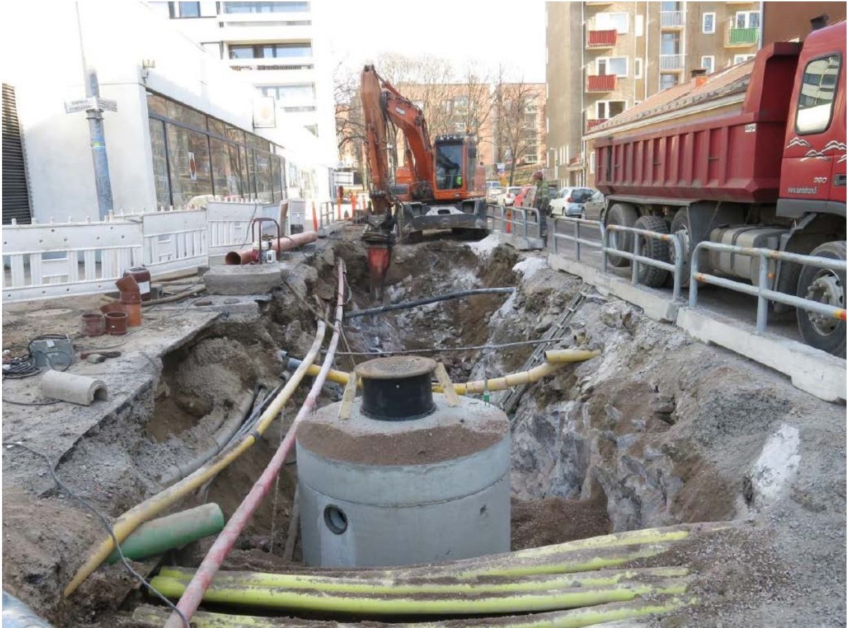
Kuva 7. Tekeillä on vesihuollon saneeraus tiiviillä kaupunkialueella. Nykyinen vesijohto ja sekavesiviemäri sijaitsevat kalliokanaalissa. Sekavesiviemärin kokoa täytyy suurentaa uuden mitoituksen mukaan, ja siten myös kalliokanaalia laajentaa. Kuvassa työkonetta laajentaa kalliokanaalia rammerilla. Rammerointia joudutaan käyttämään, koska räjäyttämisen lähellä rakennuksia ei ole turvallista. ©Sanna Rantanen
