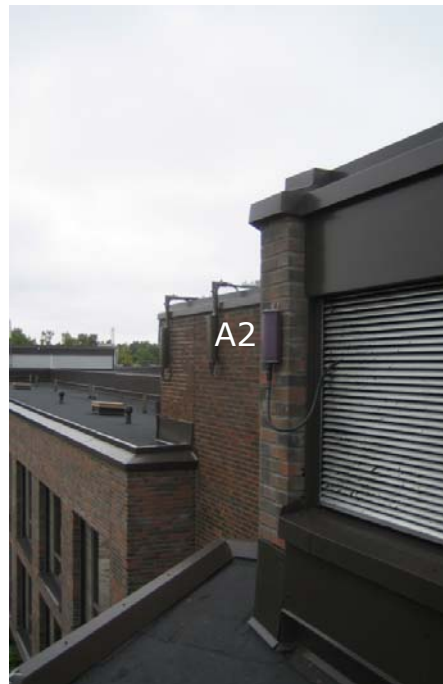
Kuva 51. Antenni A2. Mitattu tehotiheyden maksimiarvo 20 cm etäisyydestä antennin kuoresta oli 2.0 \text{ W/m}^2 .
