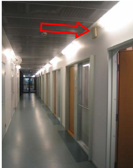
Kuva 9. Matkapuhelinverkon antenni, pikosolu.
