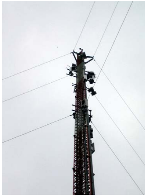
Kuva 7. Matkapuhelinverkon antennija, makrosolu.
