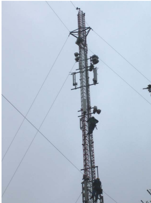
Kuva 64. Ulkoa kiivettävässä mastossa huoltomiesten on kuljettava läheltä antenneja.
