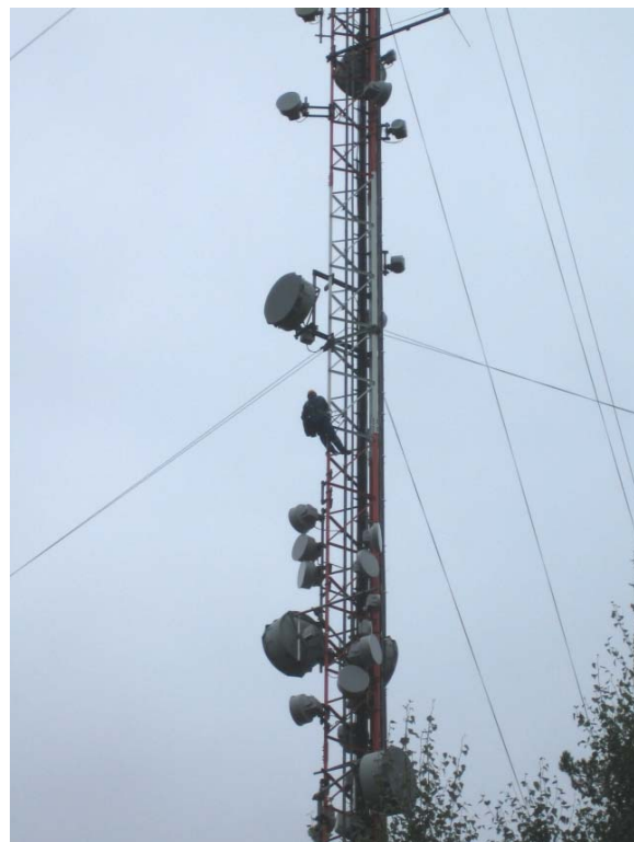
Kuva 63. Sisältä kiivettävän maston huoltoa ulkopuolelta.
