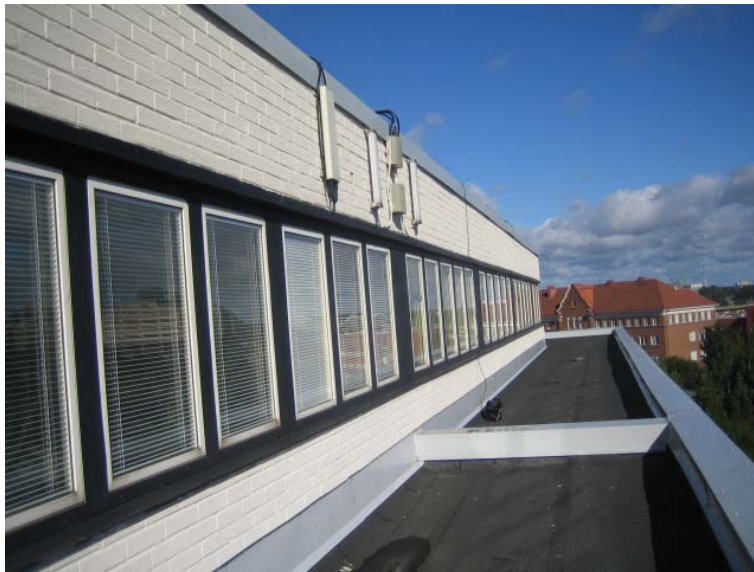
Kuva 40. Tukiasema-antennit kohteessa F.
