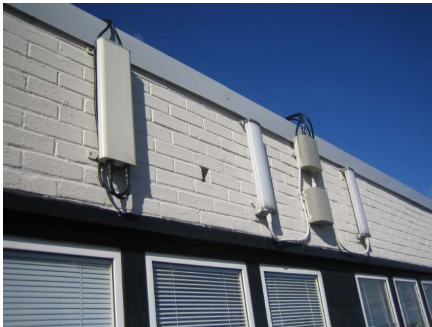
Kuva 8. Matkapuhelinverkon antennija, mikrosolu.
