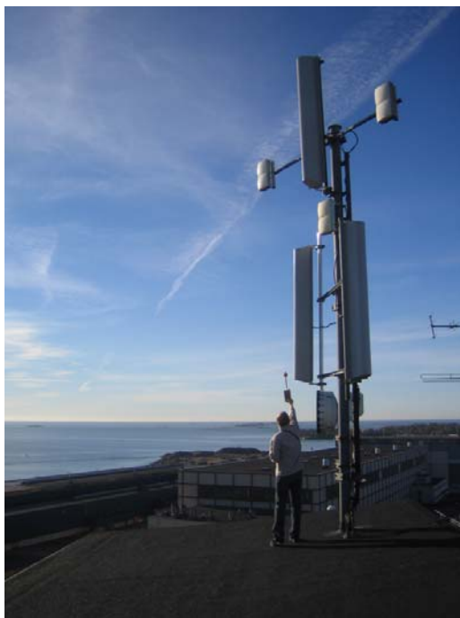
Kuva 55. Katolla sijainneet tukiasema-antennit kohteessa J.
