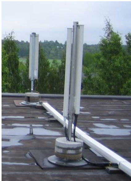
Kuva 21. Tukiaseman antennit kohteessa B.
