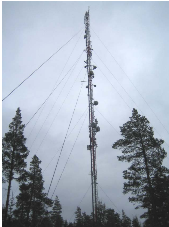
Kuva 58. Sisältä kiivettävä VU-1200 tyyppinen masto.
