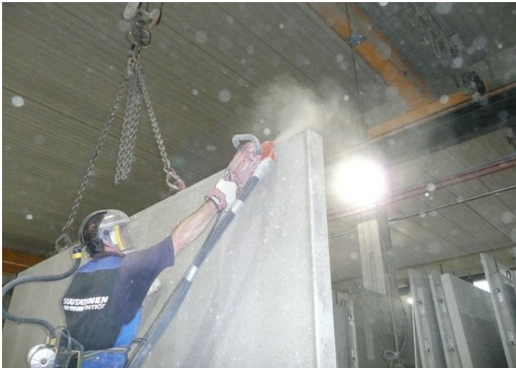
Kuva 10. Seinäelementin viimeistely käsihiomakoneella, johon on kytketty pölynpoistoimuri.
