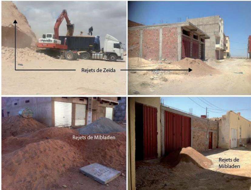
**Figure 15:** Photos illustrant l'utilisation non contrôlée des rejets miniers de Zeïda et de Mibladen comme agrégats pour la confection de mortier.
