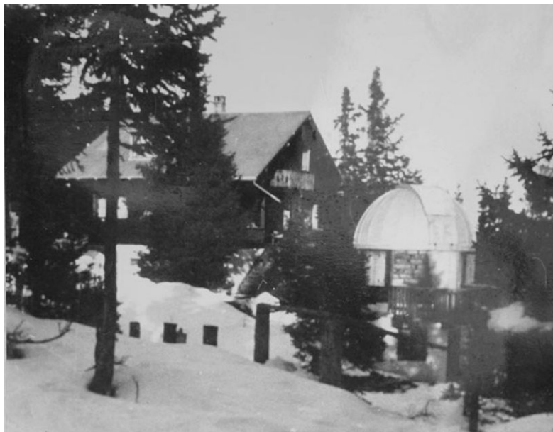
Kopuła stronomiczna na Stacji Obserwacyjnej w Arroście
