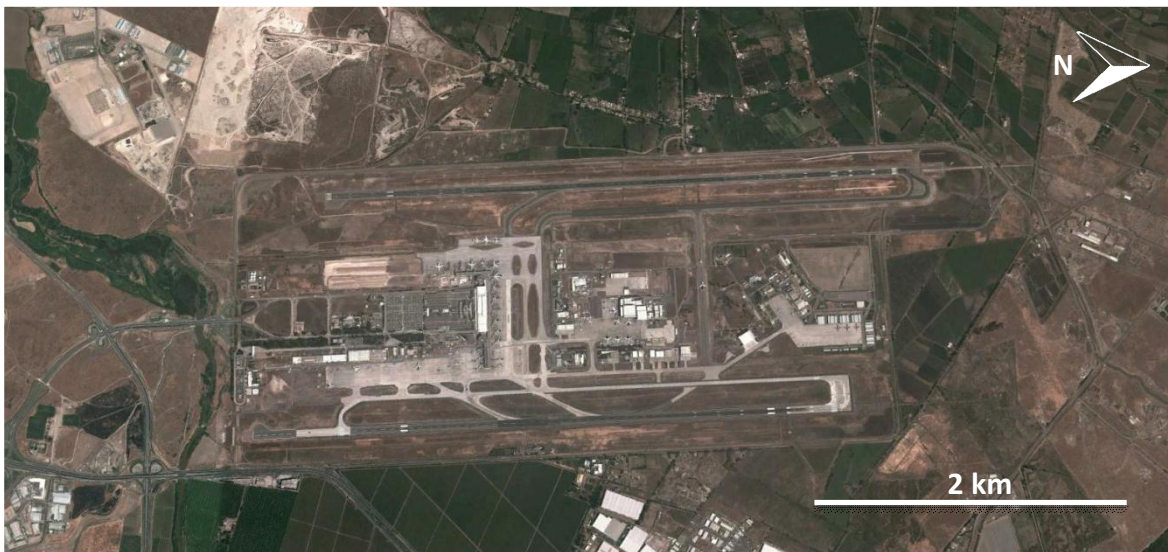
Fig. 1 - Vista general del aeropuerto.
