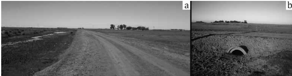
Figura 3. (a) Área de marisma donde se observa un camino interno que carece de drenes; (b) camino interno con caños de drenaje obstruidos.
