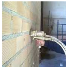
A.T.: Poliuretano inyectado e.= 4,00 cm
