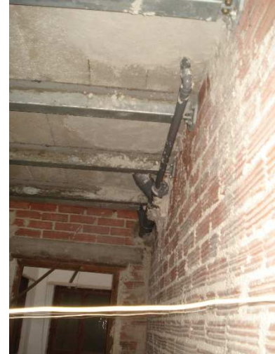
Fotografía 06: Pared de carga de ladrillo cerámico perforado
