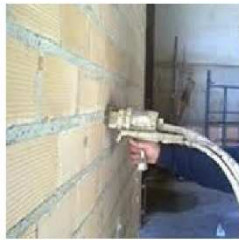
A.T: Poliuretano inyectado e.= 4,00 cm
