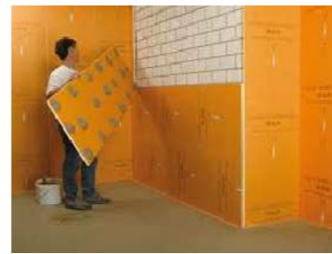
A.T.: Panel de espuma rígida extruida, Schlüter KERDI-BOARD e.= 5,00 cm
