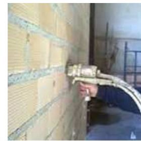
A.T.: Poliuretano inyectado e.= 4,00 cm
