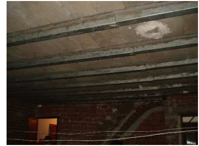
Forjado segundo (suelo planta segunda)
