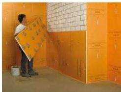
A.T: Panel de espuma rígida extruida, Schlüter KERDI-BOARD e.= 5,00 cm
