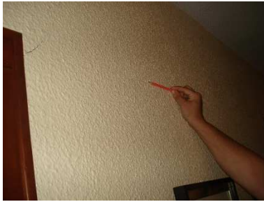
Grieta en pasillo de la vivienda tipo A de la planta segunda
