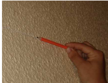
Grieta en pasillo de la vivienda tipo A de la planta segunda
