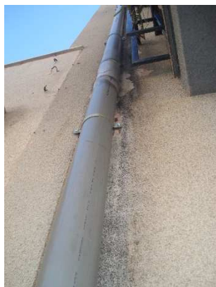
Bajante de pluviales en planta baja.....Suciedad acumulada en cubierta
