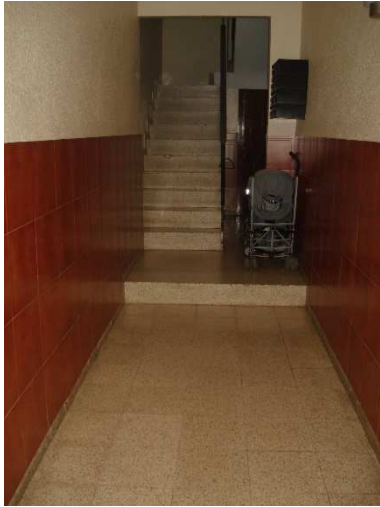
Fotografía 16: Humedad de condensación en carpintería sin rotura de puente térmico
