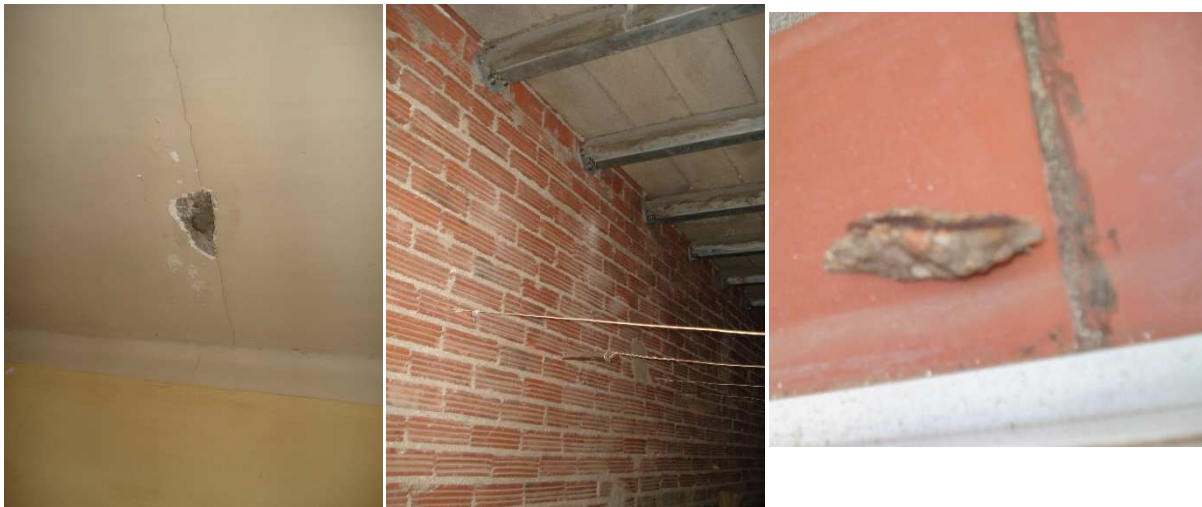
Fotografía 01: Cata en forjado segundo
