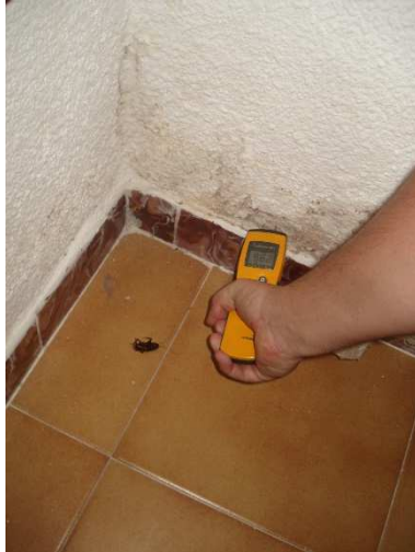
Fotografía 04: Pared de carga de bloques de hormigón macizo
