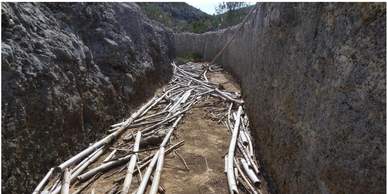
La acequia que recoge el desagüe del Molí de la Toneta, y excavada en la piedra la lleva hasta abastecer el molino.
