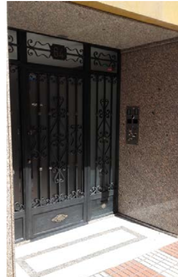
PORTAL DE ACCESO
