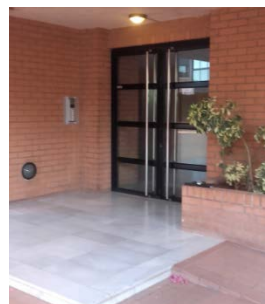
PORTAL DE ACCESO
