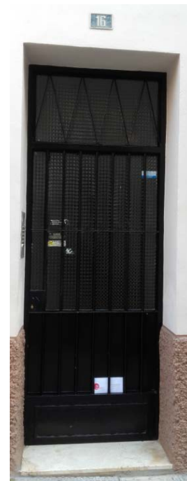
PORTAL DE ACCESO
