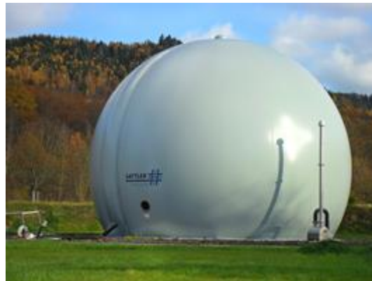
Figura 3.3.1.1: Gasómetro de doble membrana Sattler DMGS.
