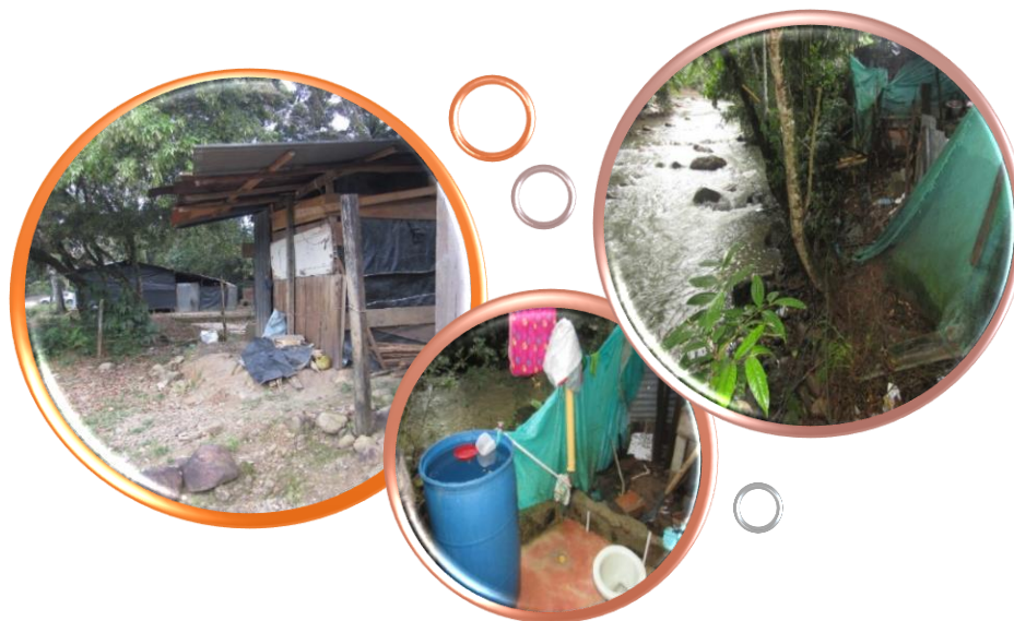
Figura 44. Material de construcción y situación de algunas viviendas en Portal de Bajo Caldas
