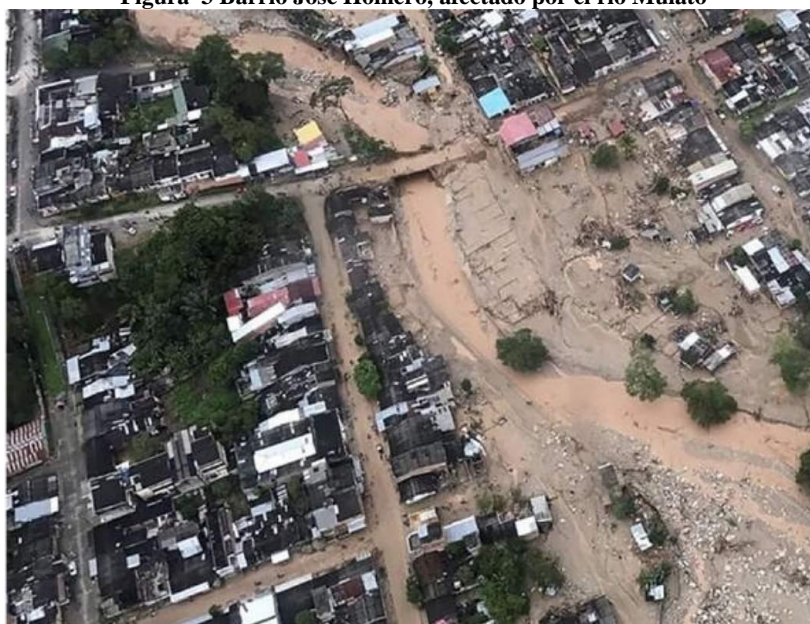
Figura 3 Barrio José Homero, afectado por el río Mulato
