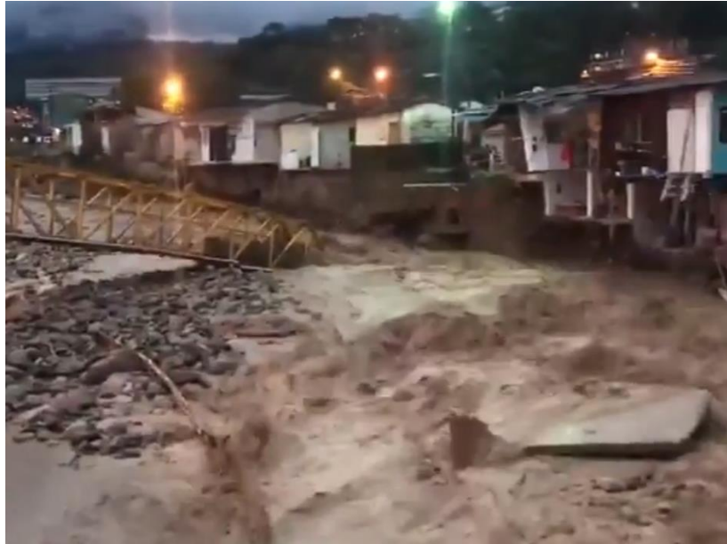
Figura 4 Barrio Avenida 17 de julio, afectado por el río Mulato
