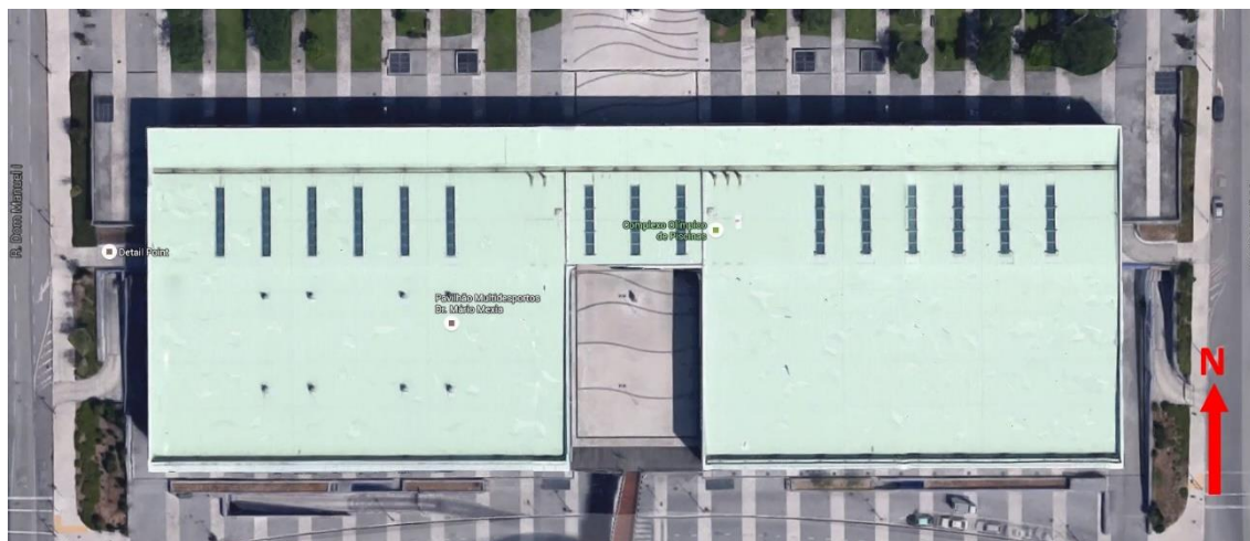
Figura 7 - Vista aérea do COPM
