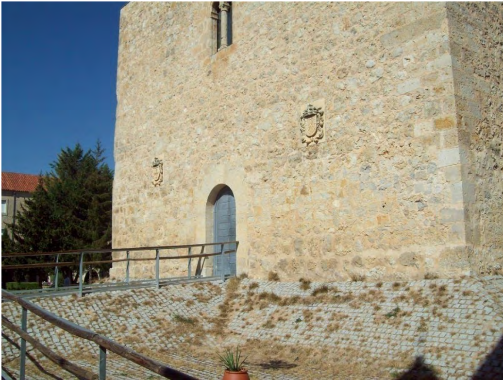
Torreón de los Guzmanes. Convento de los PP. Dominicos. Caleruega.
