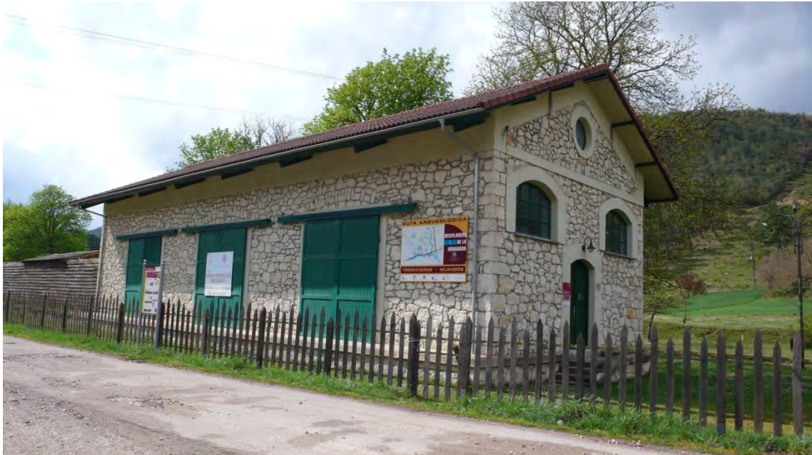
Edificio que alberga el Centro de Interpretación del Desfiladero de la Horadada. Trespaderne.
