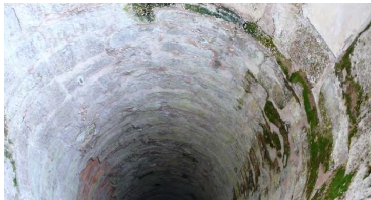
Vista del pozo que abastecía de agua al Castillo de Burgos.
