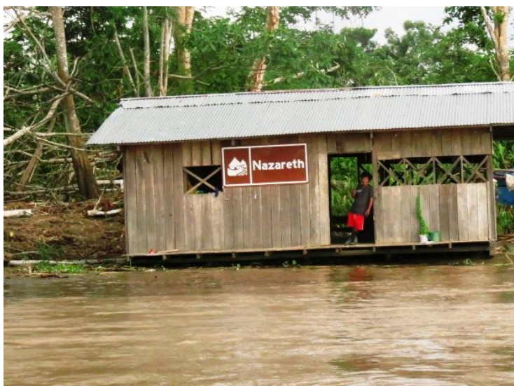
Imagen 3. Puerto del resguardo de Nazareth sobre el Río Amazonas
