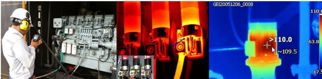
Ilustración 4: Inspección por termografía. [3]
