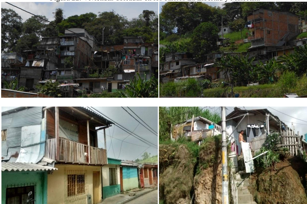
Figura 22. Viviendas ubicadas en los barrios La Libertad y Matecaña
