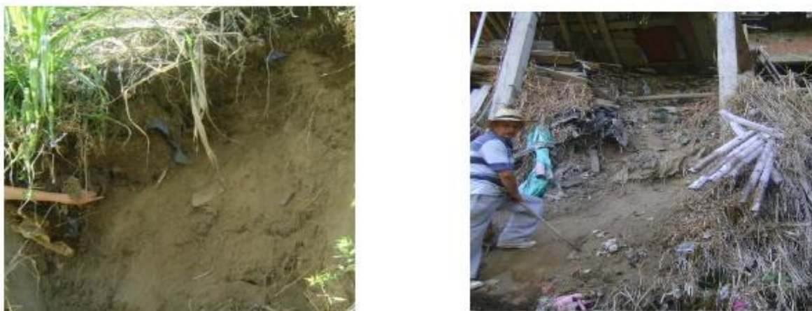
Figura 3. Depósitos Antrópicos Junto a la escuela del barrio La Libertad y Bajo el Primer Nivel de una Vivienda
