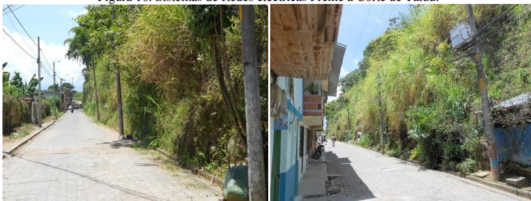
Figura 16. Sistemas de Redes eléctricas Frente a Corte de Talud.
