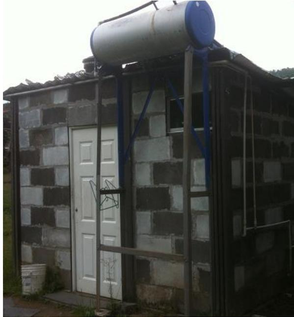
**FIG 17 Colector solar instalado en casa de ladrillo plástico**
