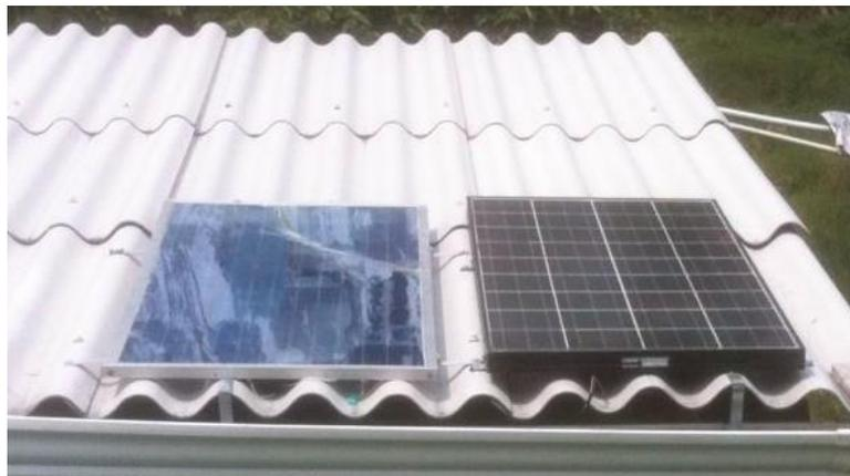
**FIG 3. Paneles utilizados de 100w y 130w**
