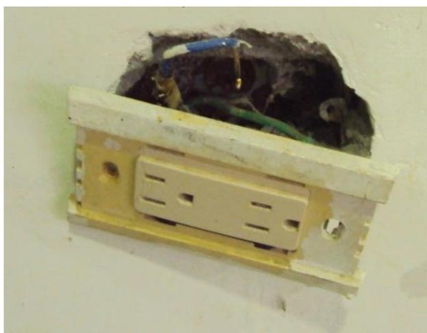
**Figura 28.** Tomacorrientes en mal estado 2.
