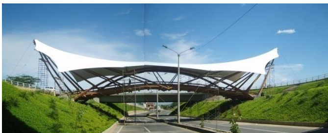
Imagen 2. Puente de guadua en Cúcuta
