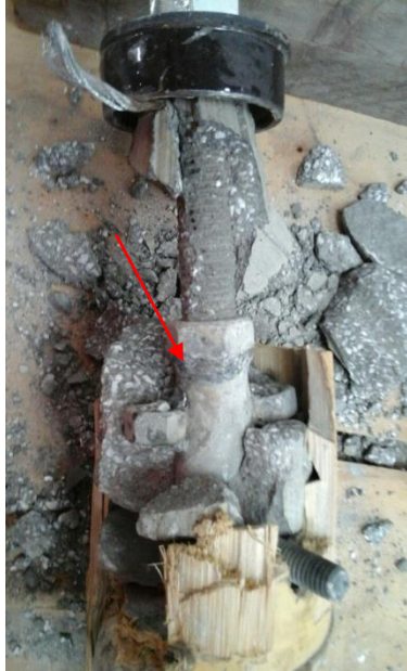
Figura 24. Soldadura del sujetador completa
