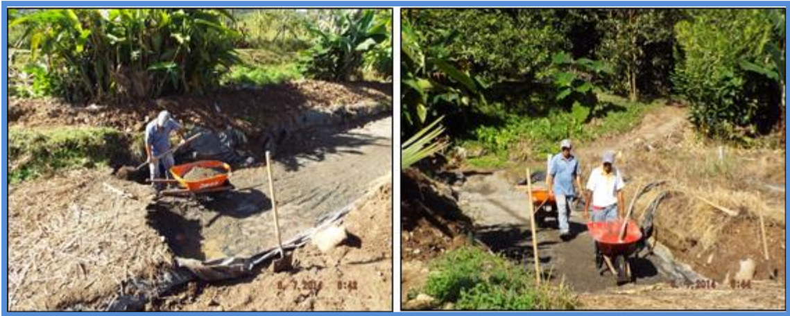
Figura 20. Excavación y traslado de material removido. Unidad experimental N° 10. Fuente: GIAS
