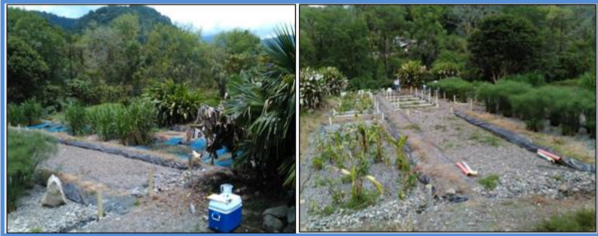
Figura 26. Sistemas contruidos y adecuados para inciar la etapa de aclimatación de las plantas y el proceso de operación y monitoreo. Humedales hibrido plantado y humedales horizontales. Fuente: GIAS
