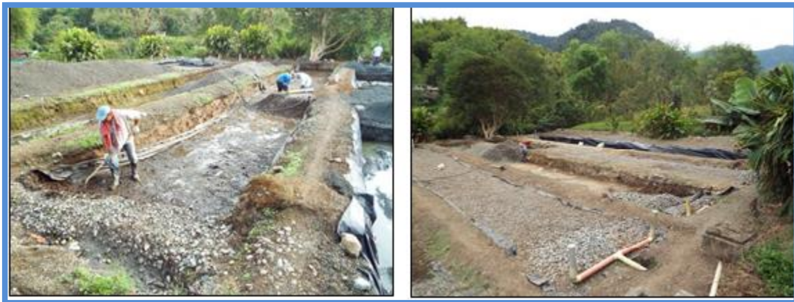
Figura 23. Excavacion de material. Unidades experimentales N°8 y N°7. Fuente: GIAS
