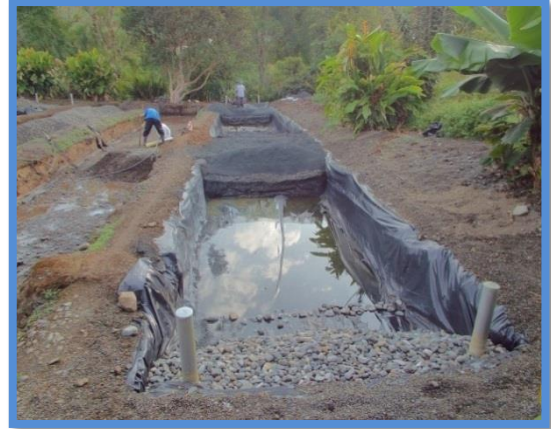
Figura 22. Tuberías y medio filtrante instalados. Unidad experimental N° 10.
