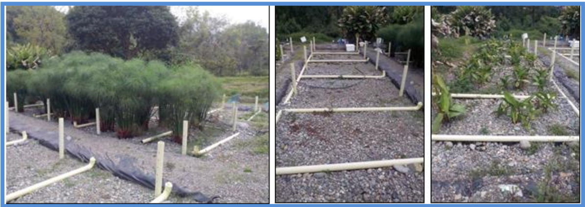
Figura 27. Distribución sistema de alimentación de Humedal vertical plantado con papiro y heliconeafuente: GIAS
