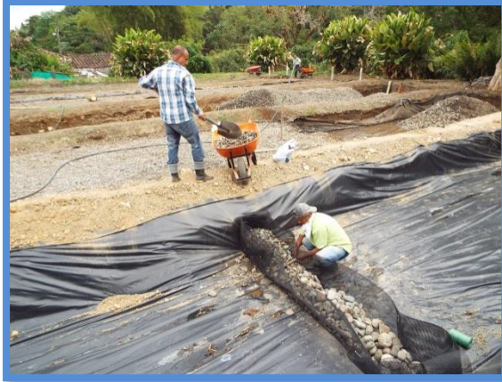
Figura 21. Adecuación de diques permeables. Unidad experimental N° 9.
