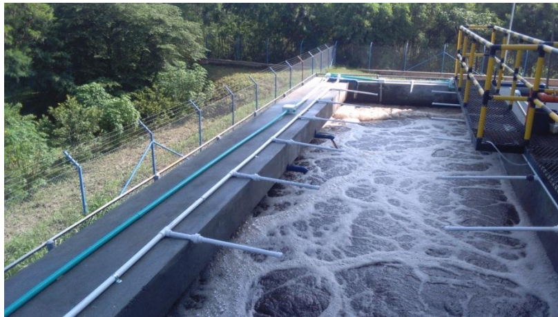
Figura 1. Tanque homogeneizador y de contingencia respectivamente.
