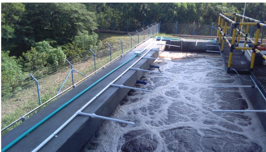
Figura 16. Tanque de aireación extendida.
