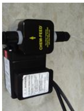
Figura 12. Dosificadora de coagulante.
