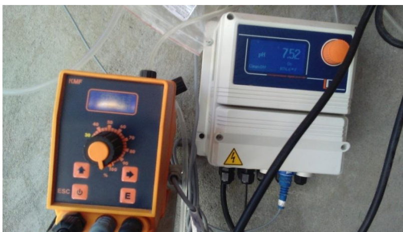
Figura 18. Medidor de pH y dosificador de soda caustica.
