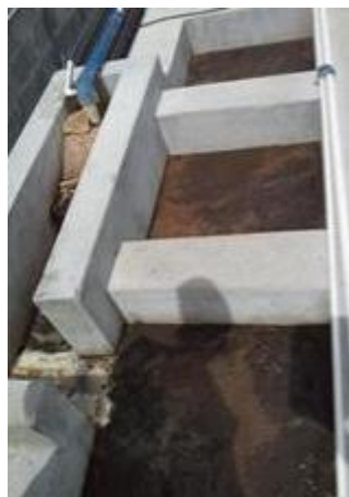
Figura 11. Unidad de coagulación y floculación.
