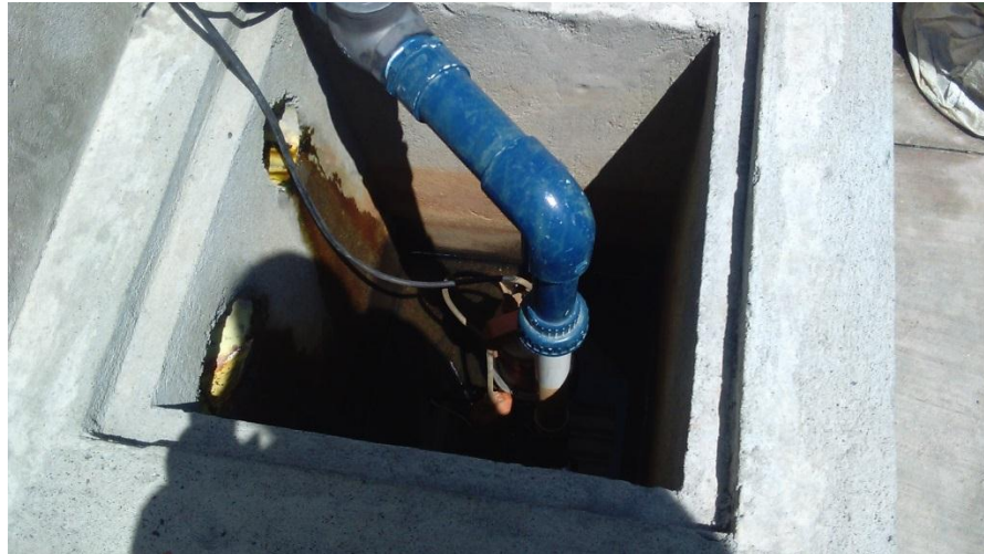
Figura 22. Tanque de lixiviados.
