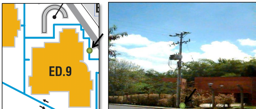
Imagen 33. Lugar de la medición del SPT de la Biblioteca - Transformador.
