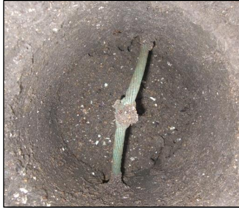
Imagen 43. Estado del SPT del Edificio de Bellas Artes.
