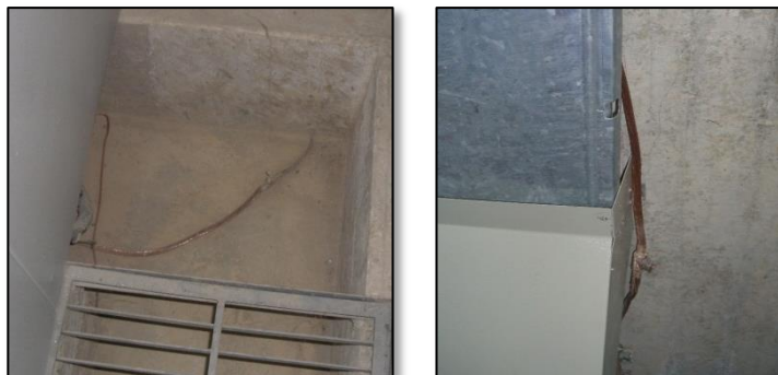
Imagen 52. Estado del SPT del Centro de Innovación.
