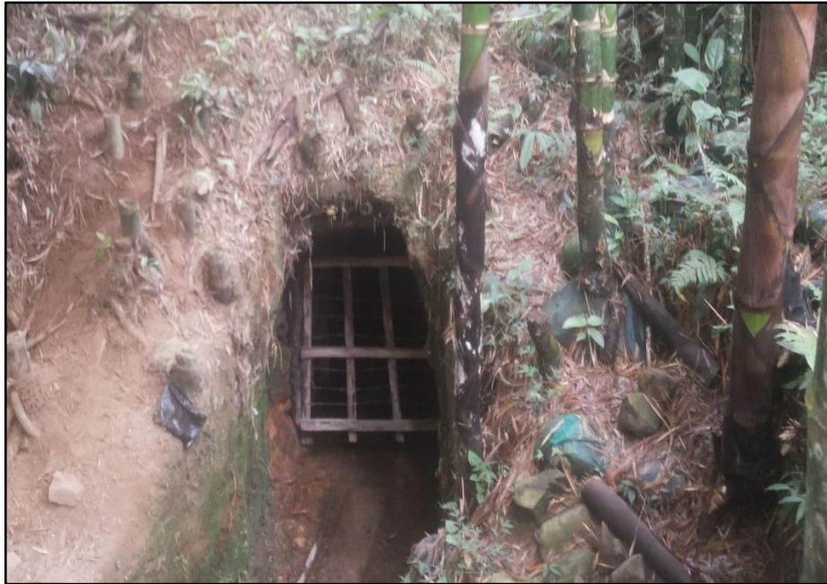
Figura 16. Mina de Túnel, vereda La Cumbre
