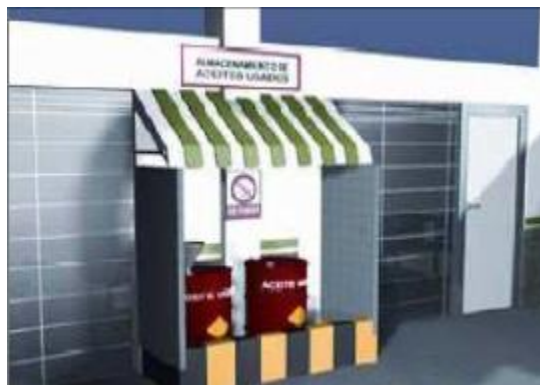
FIGURA 11 Almacenamiento de aceites y lubricantes
