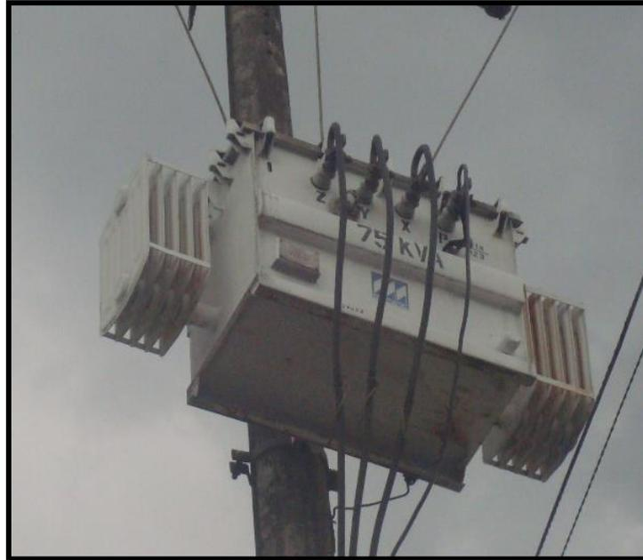
Figura 1 Línea de alimentación, Transformador de 75 kVA
