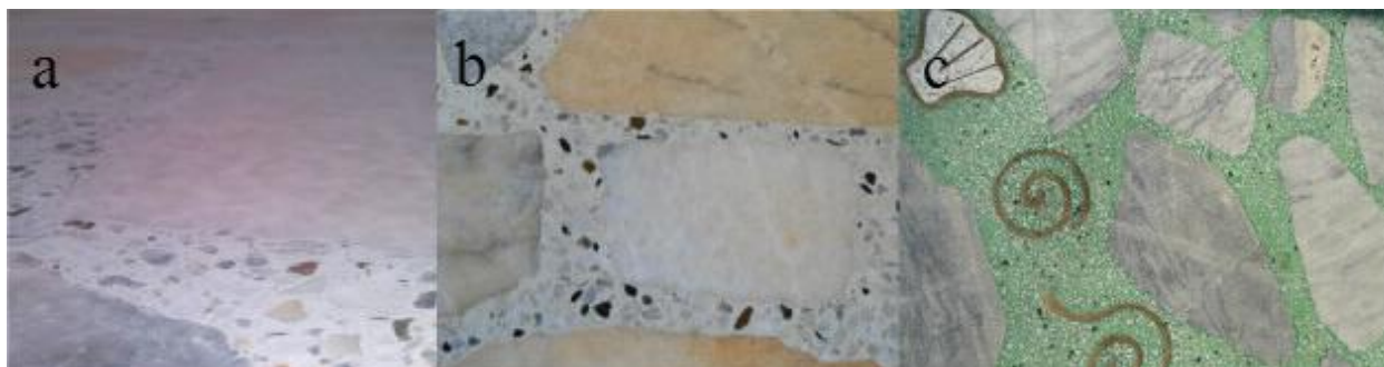
Figura 2. a) piso de mármol y granito, b) piso de mármol y granito y c) piso de mármol y granito con figuras decorativas en bronce.
