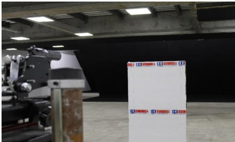
Fig. 4. Montaje de la lámina de Drywall. Fuente: propia.
