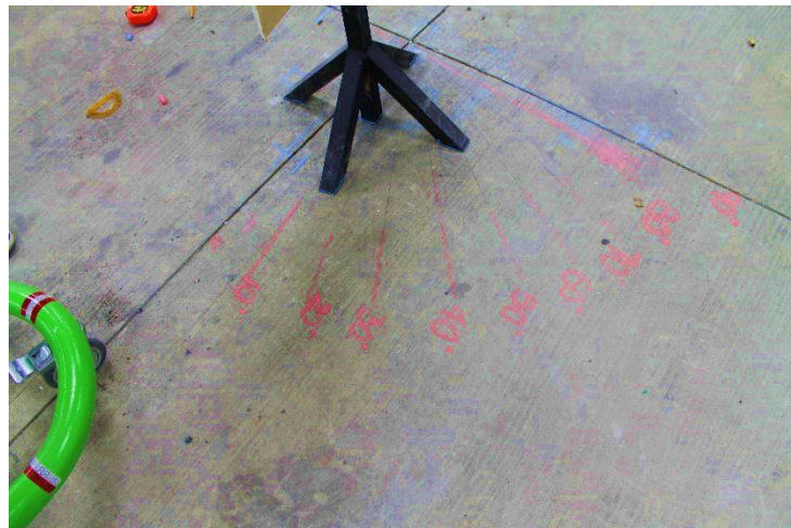
Fig. 6. Desplazamiento de la base de la lámina de Drywall. Fuente: propia.
