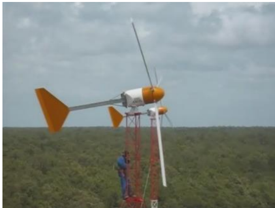
Figura 19 - Aerogerador de uma torre atirantada
