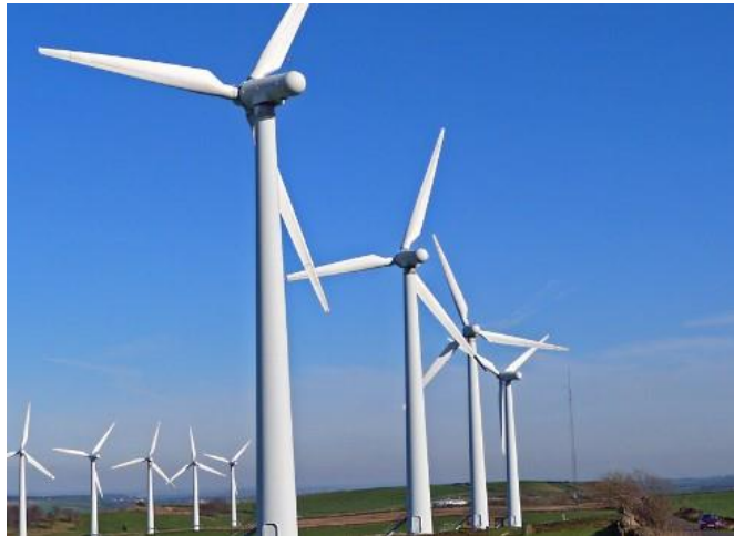
Figura 16 - Torre eólica com secção tubular
