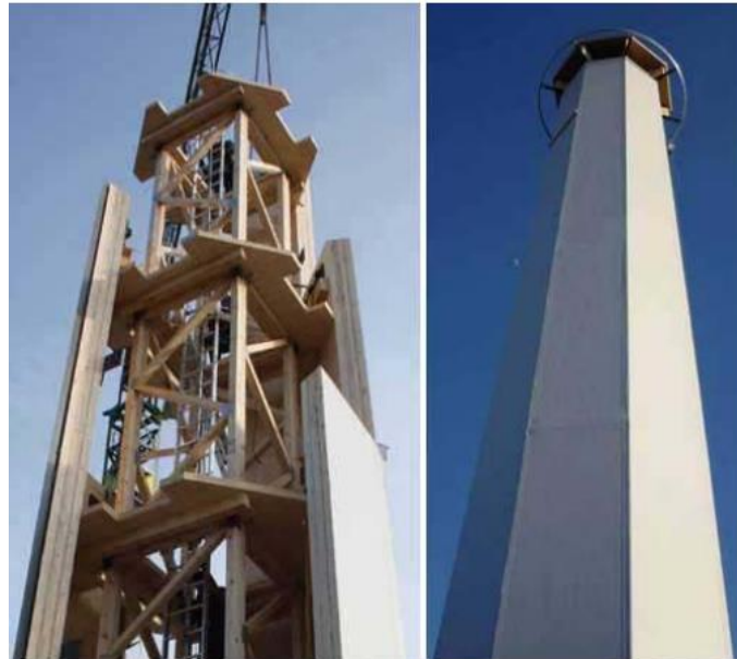
Figura 24 - Torre de madeira com um aerogerador de 1.5 MW [21]
