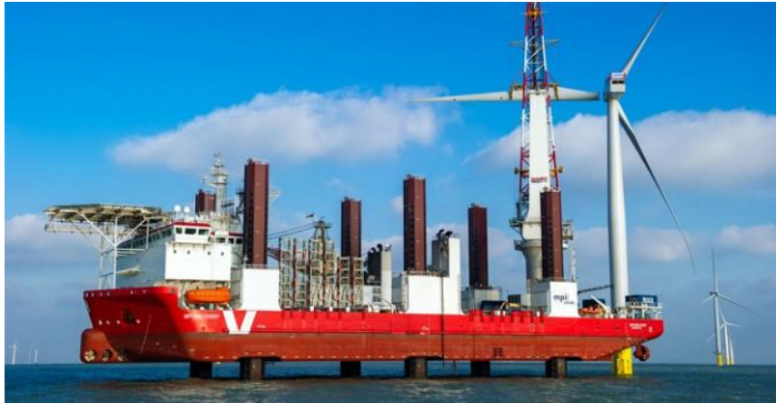
Figura 13 - Construção de um aerogerador offshore [14]
