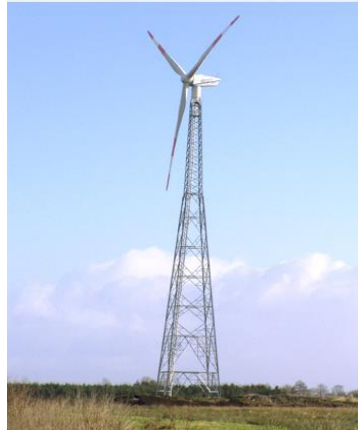
Figura 18 - Torre eólica com secção treliçada
