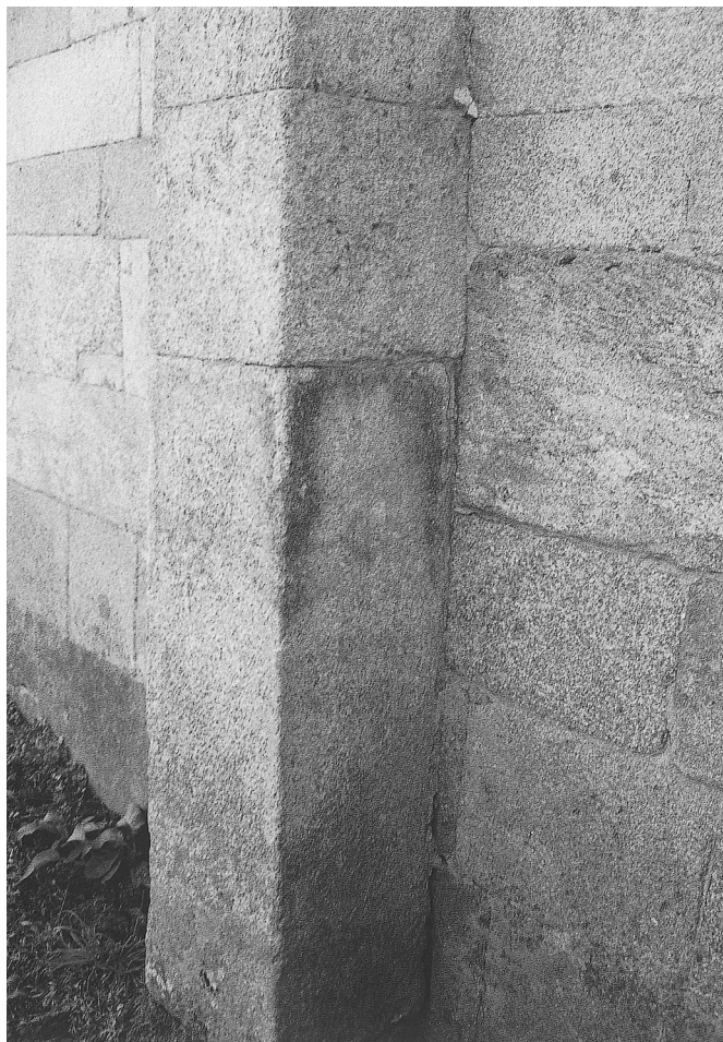
LÁMINA 5. Detalle del primer sillar de los contrafuertes adosado al muro sin penetrar en él (Vázquez Rozas, 2006).
