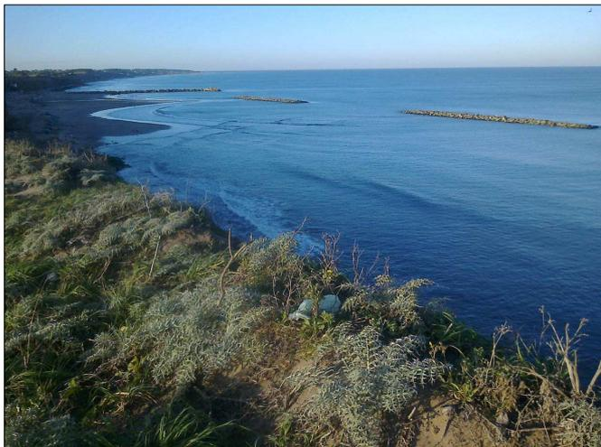
Se planteó un diseño de playa con formación de salientes - no serán tómbolos-, a fin de inducir y facilitar el movimiento del sedimento a lo largo de la costa. Aún se evalúa y monitorea si la distancia de los rompeolas a la costa es suficiente para dicho transporte que, de por sí está obstaculizada por el espigón perpendicular aún no retirado.
