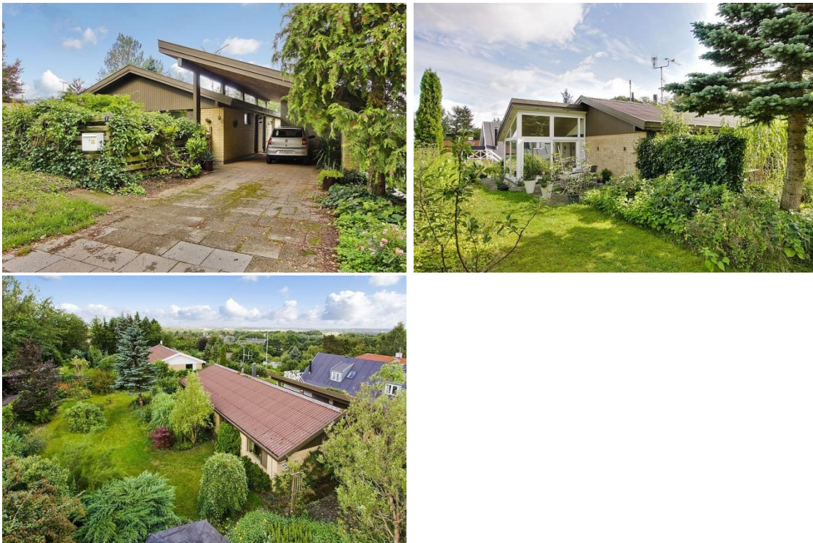
Figur 8 – Billeder af huset i Ballerup taget i forbindelse med salg. Øv.tv. ses huset fra vejen (NØ), med carportaget der rager ind over selve huset. Øv.th. ses glastilbygningen der forlænger husets vestgavl (SV). Nederst ses husets sydfacade der vender ud mod haven (SØ).
