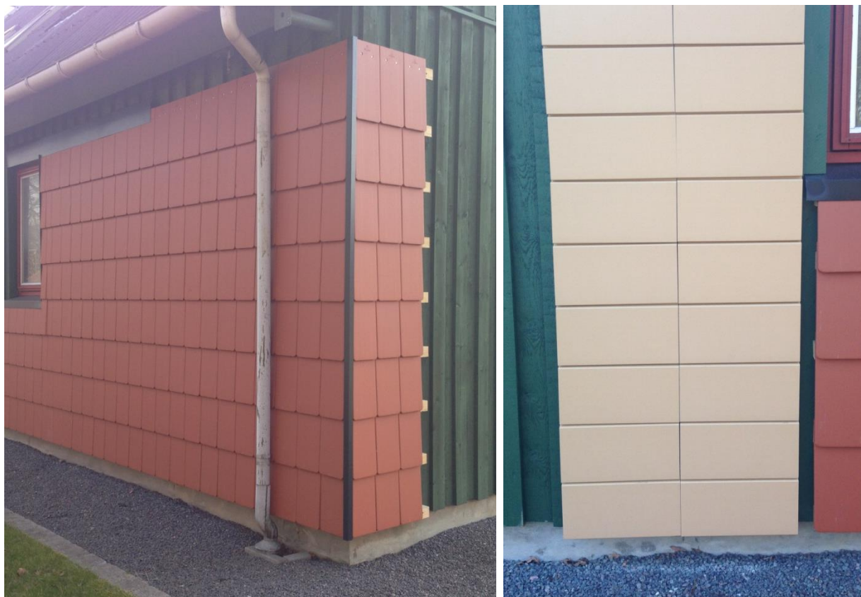
Figur 16 – De to teglløsninger som de er opsat på forsøgshuset. TV. ses bæverhaletegl opsat på et vægstykke omkring et hjørne og et vindue, TH. ses skærmteglløsningen opsat på et vægstykke.
