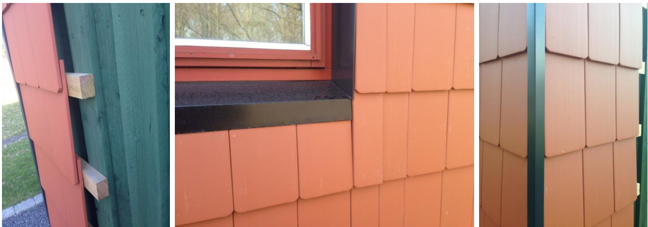
Figur 17 - Detaljebilleder af bæverhaleløsningen.
