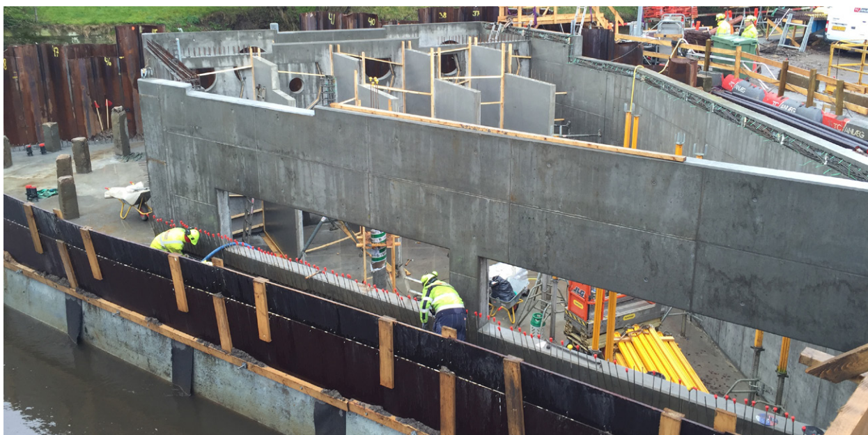
Opførelse af pumpeump, teknikum og oppumpningskammer.
