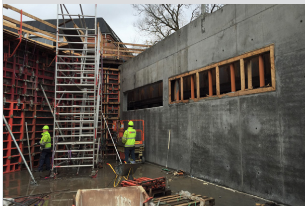
Pumpesumpen under opførelsen
