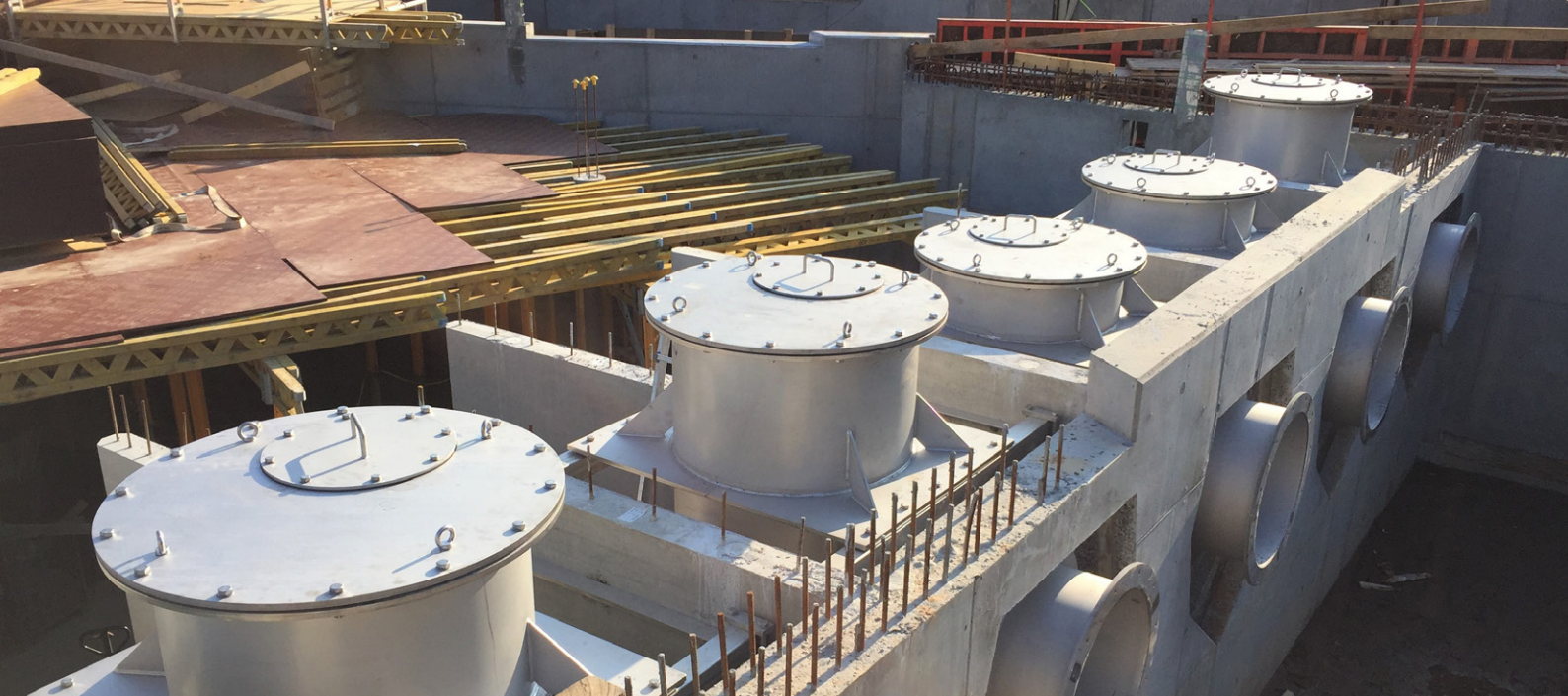
Skaktrør til de fem pumper under byggeriet.
