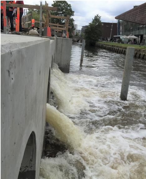
Udløb fra pumpesump set fra modsat side af åen.
