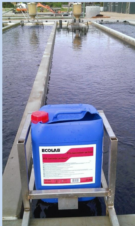
Beholder til brug i forbindelse med manuel dosering af pereddikesyre; tilførslen af PAA fra beholderen foregik over en time.
