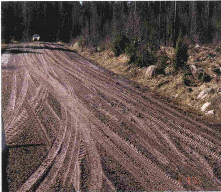
Kuva 4. Esimerkki pintakelirikkoisen tien pinnasta.
