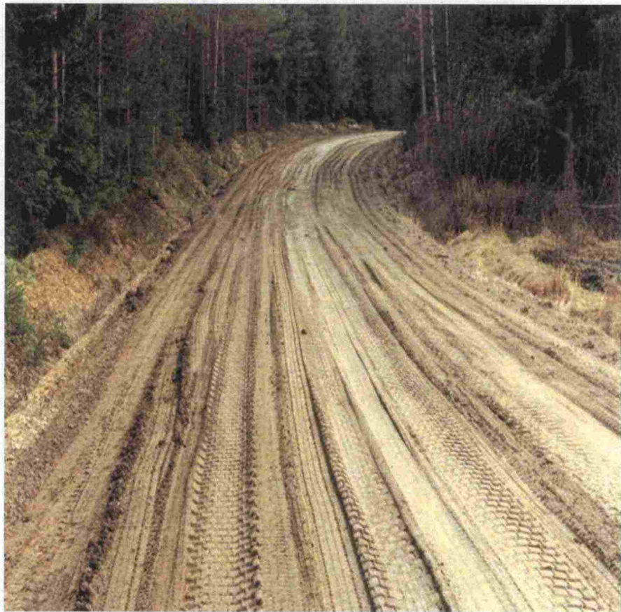
Kuva 3. Esimerkki pintakelirikkoisen tien pinnasta.
