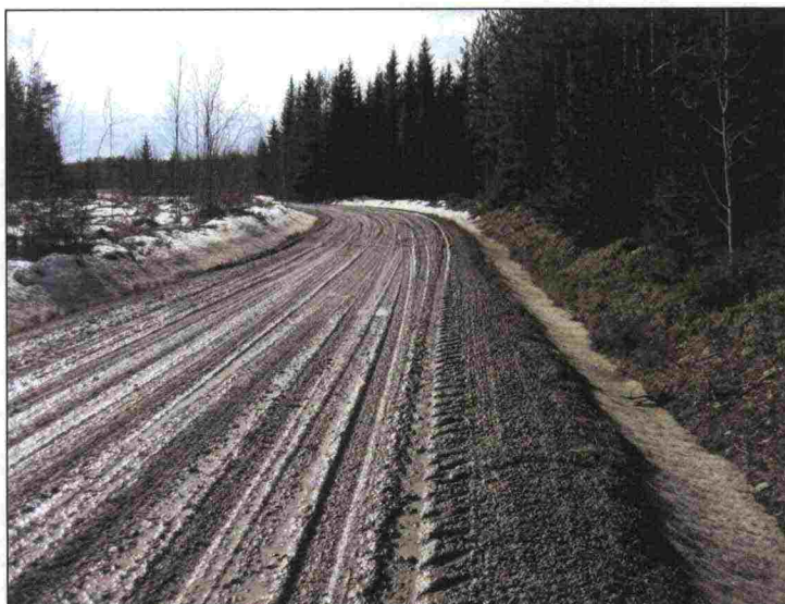
Kuva 2. Maantie 17353, kuva keväältä 2006.
