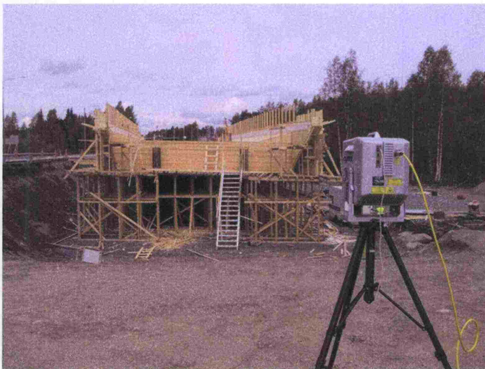
Kuva 27. Sillan eteläisen muottipäädyn keilaus.
