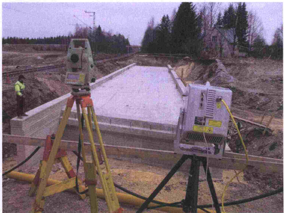
Kuva 40. Kaplaan sillan laserkeilaus käynnissä.
