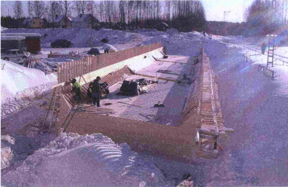
Kuva 54. Sillan muotin tarkastusmittaus takymetrillä käynnissä (Kaplaan silta, Suonenjoki). Talviolosuhteet olisivat haitanneet ja mahdollisesti jopa estäneet muotin laserkeilauksen.
