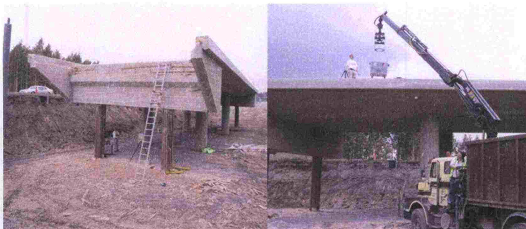
Kuvat 29-30. Käytännön mittausgeometriaa kesällä 2004 S17-työmaalla. Laserkeilauslaitteisto jouduttiin nostamaan ajoneuvonosturilla sillan kannelle ja sieltä takaisin maanpinnalle.
