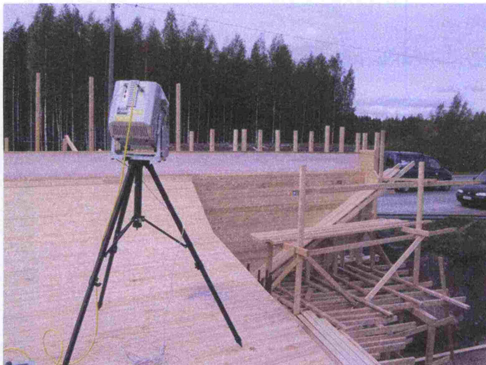
Kuva 26. Siipimuurin muotin keilaus.
