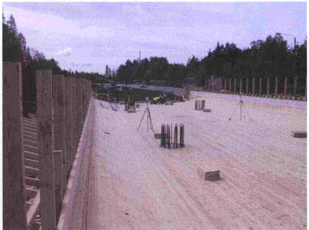
Kuva 25. Reunapalkkien muottien taiteviivojen keilaus.
