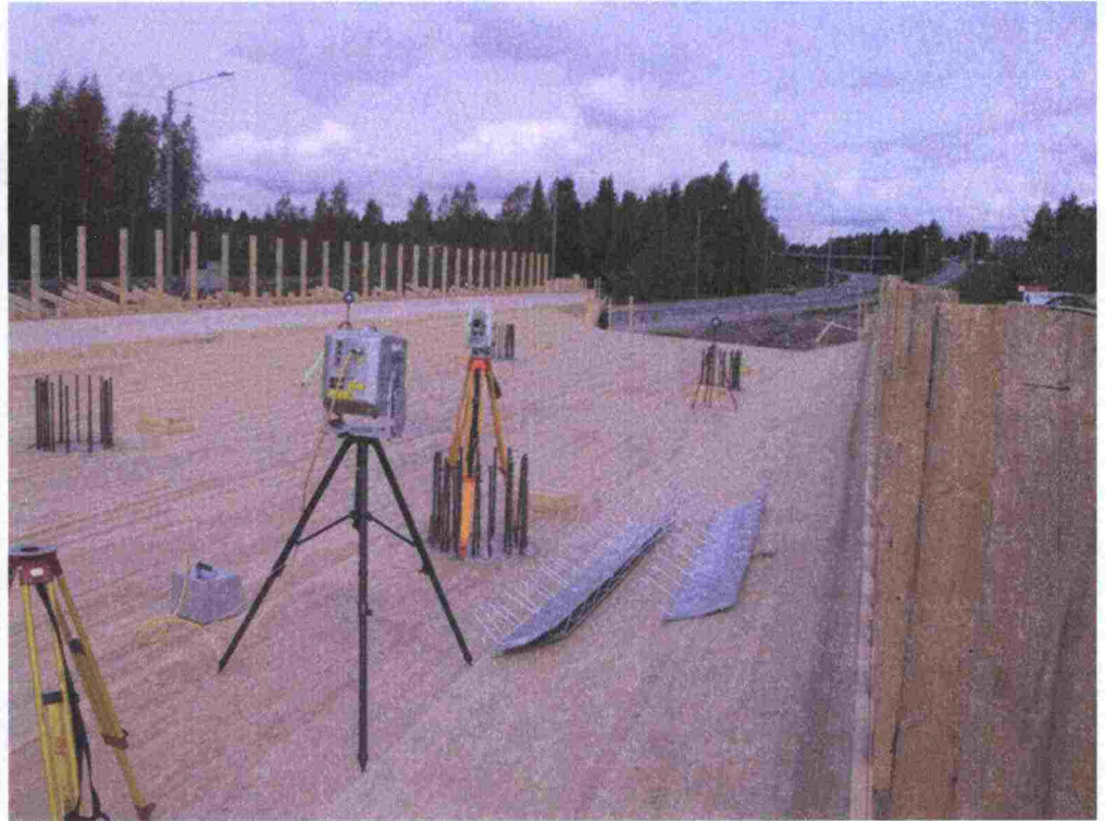
Kuva 24. S17-muotin laserkeilaus muotin päältä.
