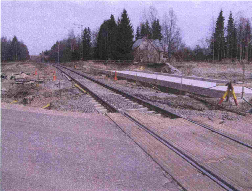
Kuva 41. Silta siirretään myöhemmin olemassaolevan ratalinjan alle.
