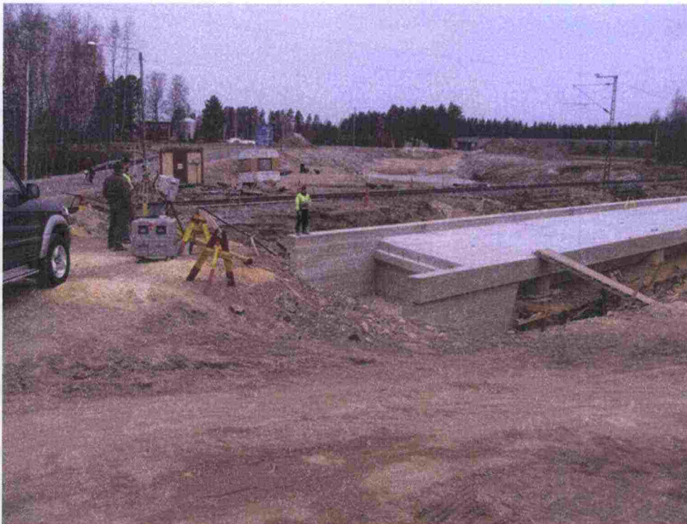
Kuva 42. Keilaus käynnissä – katveet estivät sillan alapintojen mittaukset.
