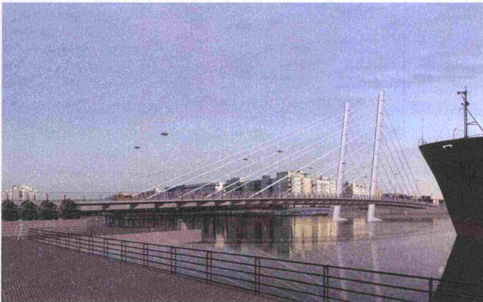
Kuva 23. Sillan yleissuunnitelmavaiheen visualisointia (Länsisatamankadun silta, Helsinki).
