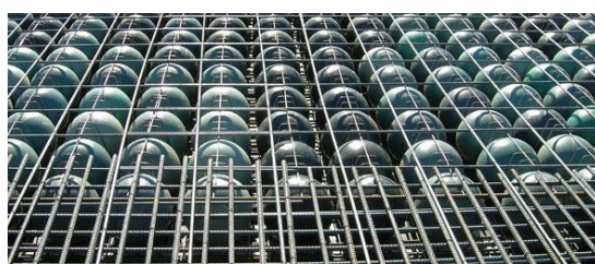
Figure 1 A Cobiax slab before concrete pour
