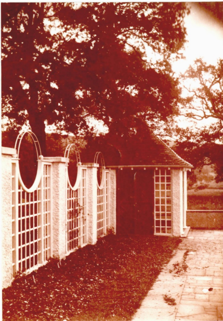
n.128 Shelter and trellis, Stocks c.1910
