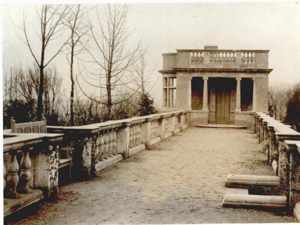
n.116 Garden house and terrace, Walmer Place c.1901
