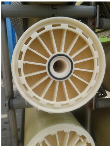
Figura 7. Imatge d'un tub amb les membranes d'osmosi inversa a l'interior. Elaboració pròpia, a l'ETAP de Sant Joan Despí (Aigües Barcelona).
