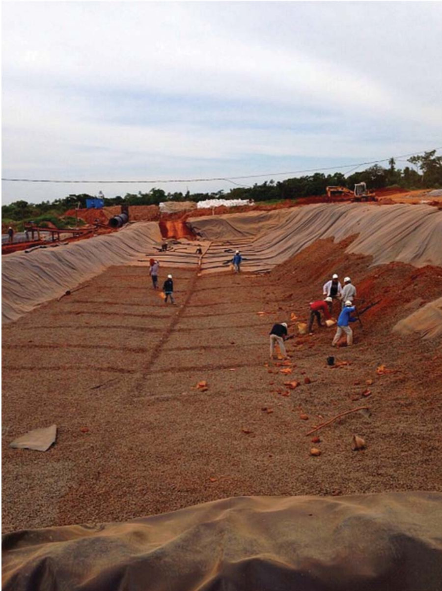
Figura 1: Construcción de estanque de lixiviación
