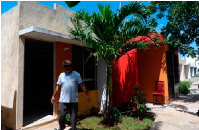
Fotografía 1. Vivienda original y vivienda ampliada
