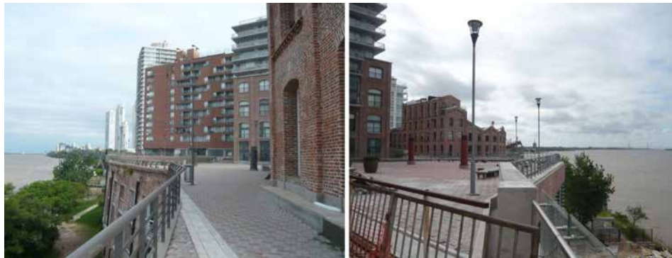
Fotografías 2. UG2 Sector 1 “Fórum”-basamento y barranca. Construcción, diciembre 2014
