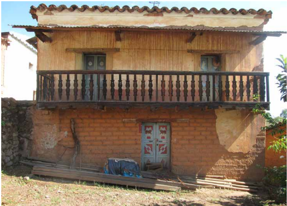
Fotografía 3. Casa construida con adobe de dos niveles
