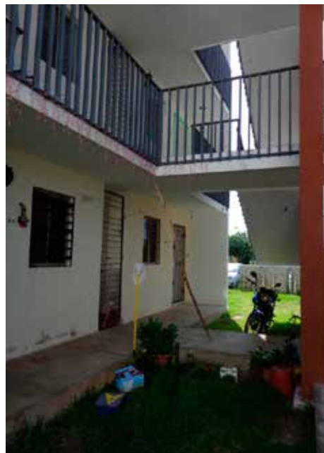
Fotografía 3. Espacio interior de la vivienda en condominio vertical Fuente: María Elena Torres Pérez.
