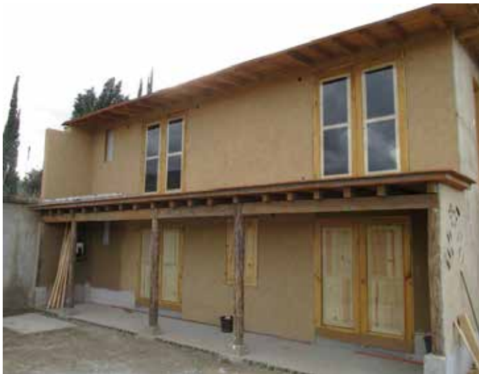
Fotografía 7. Casa de bahareque en San Sebastián Tutla, Oaxaca.
