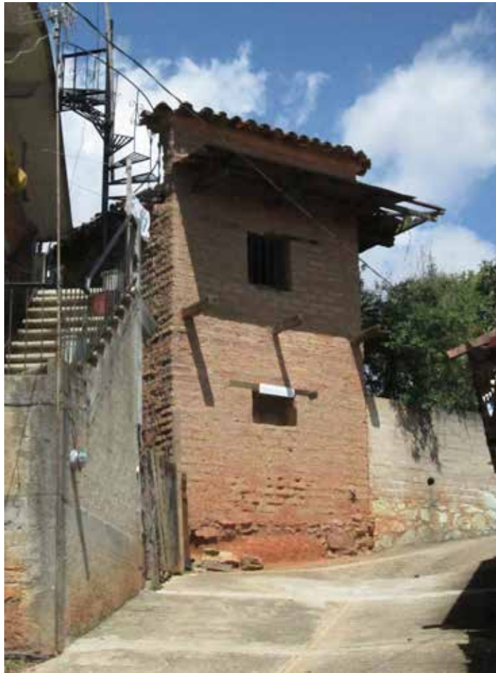
Fotografía 4. Casa de adobe de dos niveles. Se observa el contraste entre los materiales del lugar y los industrializados
