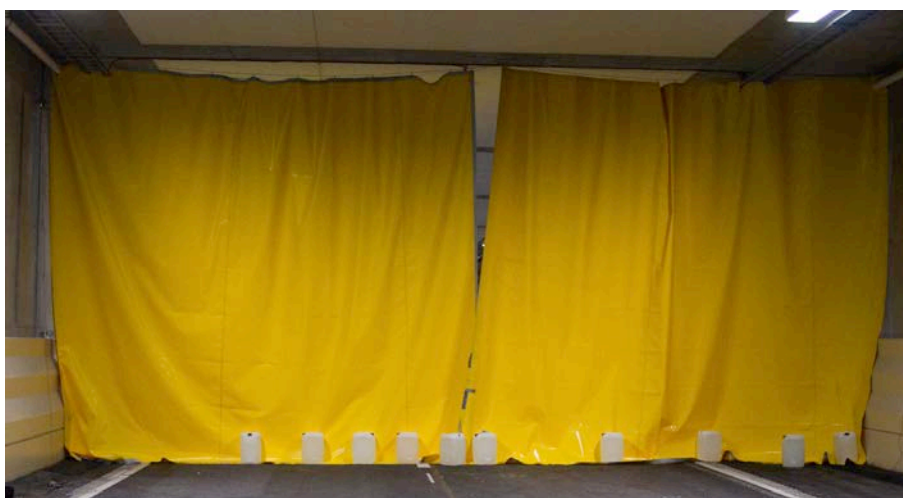
Figur 2. På grund av rådande ventilationsförhållande i Norra länkens tunnlar användes fyllda vattendunkar för att motverka trycket mot gardinerna.
