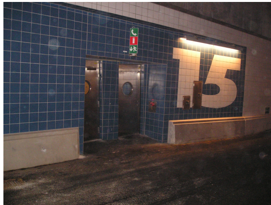
Figur 3. Ingång till en tvärförbindelse utan mellanliggande utrymme.
