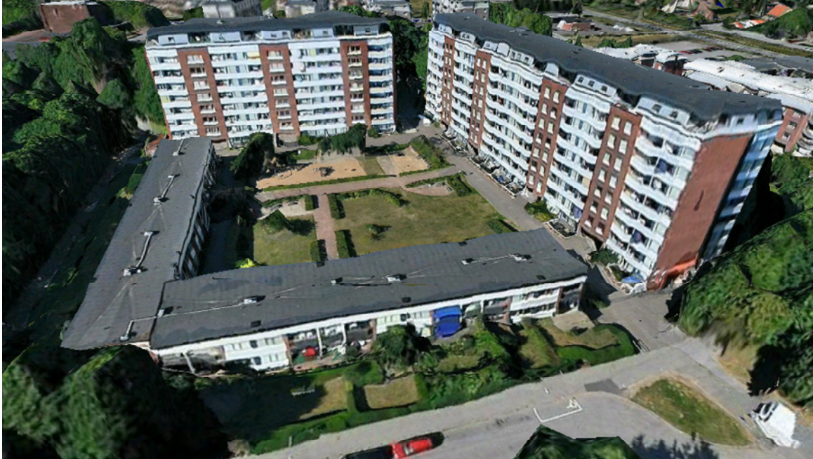
Figur B.1 Exteriör från kvarteret Snödrivan 1 (källa: hitta.se).
