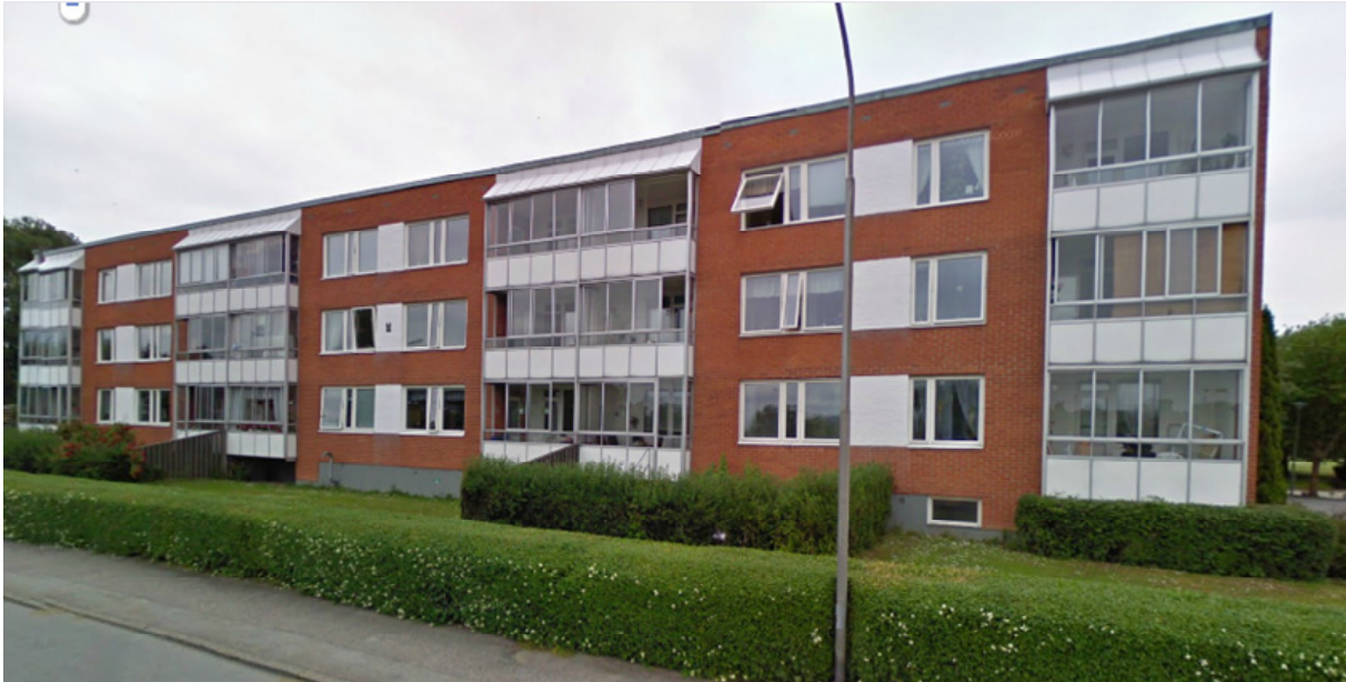
Figur B.13 Nordvästfasad utmed Gäslingavägen. (källa: Google Maps)
