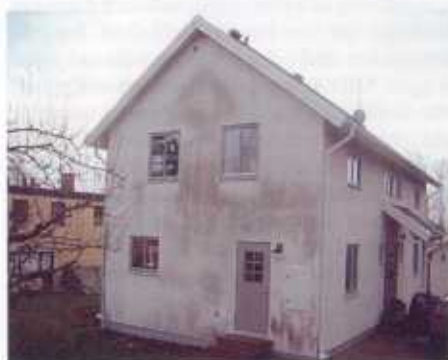
Bild 1: Fasader med kraftig påväxt av olika organismer.
