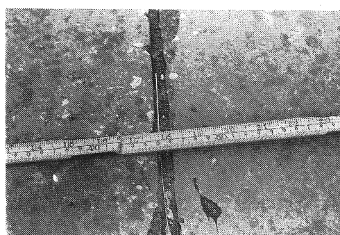
Fig. 2.12. Toiture type IV, Cité Ibn Khaldoun (a). Mauvaise application du Flintkote entre les dalles (b).
