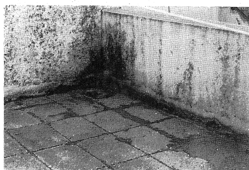
Fig. 2.12. Toiture type IV, Cité Ibn Khaldoun (a). Mauvaise application du Flintkote entre les dalles (b).
