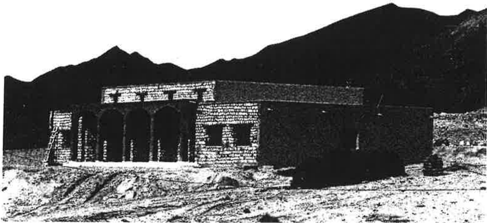
Fig. 4.3.1. La maison de jeunes à Tameghza, Tunisie. Un exemple de conception bioclimatique où l'on a utilisé des panneaux en laine de bois pour l'isolation thermique de la toiture.
