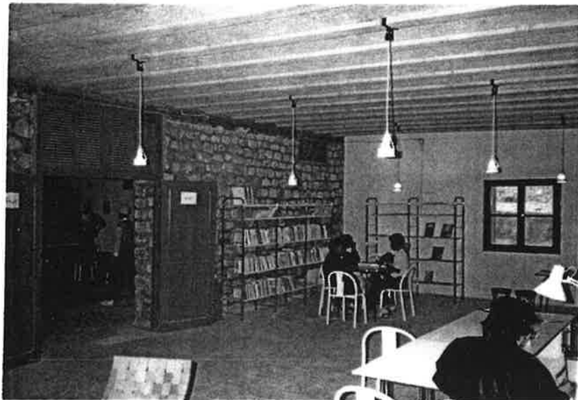
Fig. 4.3.2. La maison de jeunes à Tameghza – intérieur. Panneaux en laine de bois dans la toiture et des murs en pierre pour le stockage thermique.
