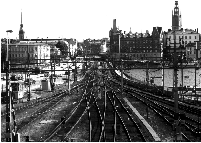
Getingmidjan och Riddarholmen norrifrån: där Stockholms Centrals alla spår blir två (Foto: H. Corvellec)
